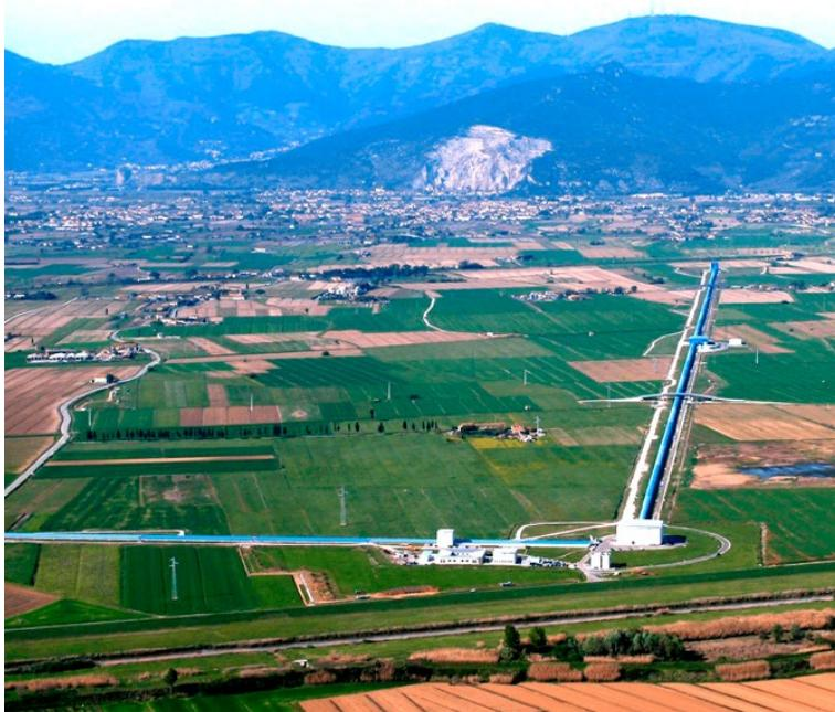
▲ L'interféromètre Virgo est situé à Cascina, en Italie. Du bâtiment central, un laser émet un faisceau lumineux qui, séparé par un miroir, va se propager dans les deux bras longs de 3 km.
